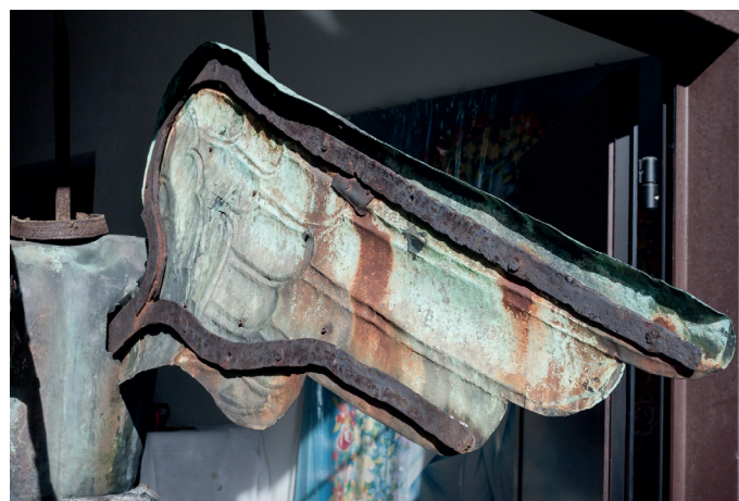
Internamente la statua presenta un asse centrale in ferro con due anelli che reggono le ali (Foto: Daniele Amrbosini)
